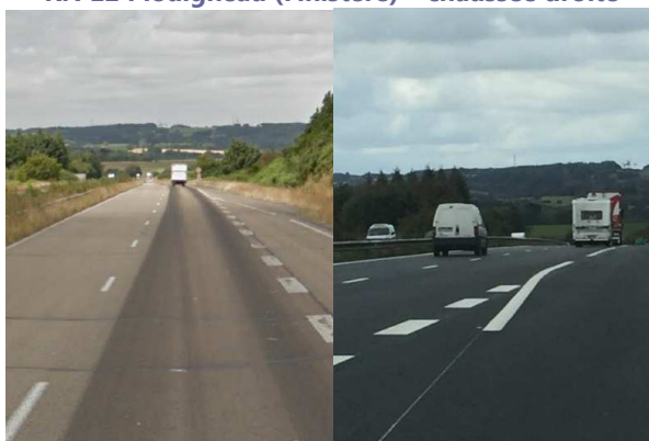
RN 12 Plouigneau (Finistère) – chaussée droite
