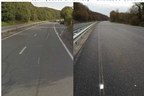
RN 176 Pleslin (Côtes d'Armor) – Chaussée Gauche
