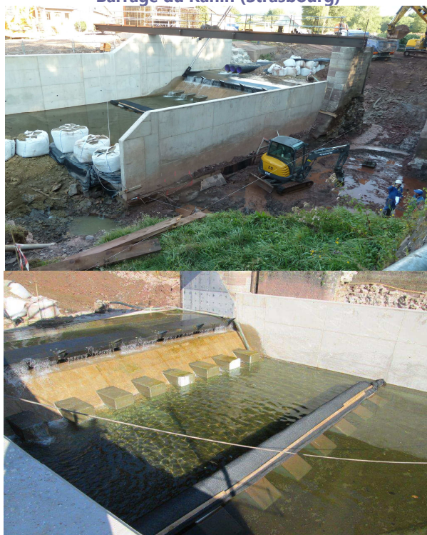
Barrage du Rahin (Strasbourg)
