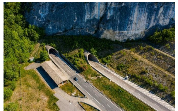
Tunnel du Vuache ©ATMB
